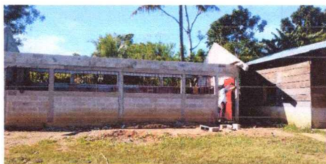
fotografía 4: Sustitución de puerta
