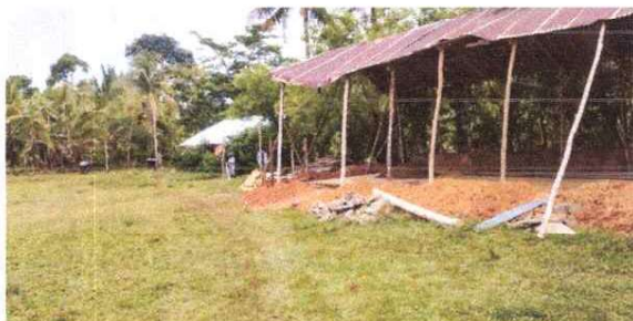
fotografía 1: Eliminación de madera causada por polilla.
