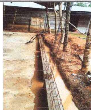
fotografía 2: Fortalecimiento cimiento de humedad
