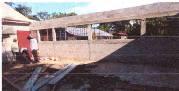
fotografía 5: Sustitución de ventanas
