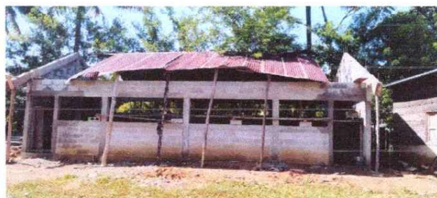
fotografía 6: Sustitución de estructura de soporte de madera, por metal
