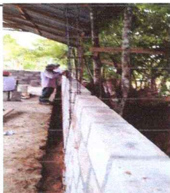
fotografía 3: Sustitución de madera a block
