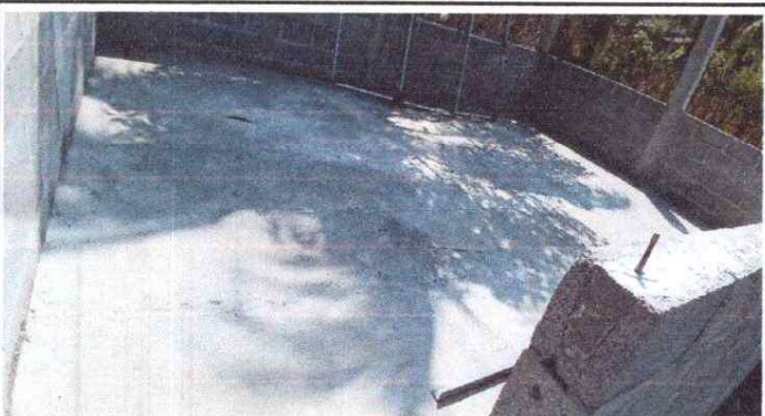
Sustitución de piso de torta de concreto
