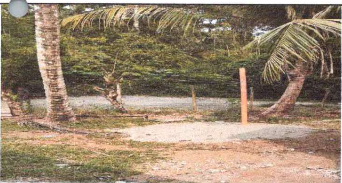
Limpieza de fosa Séptica
