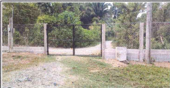
Fabricación e Instalación de Portón de Ingreso
