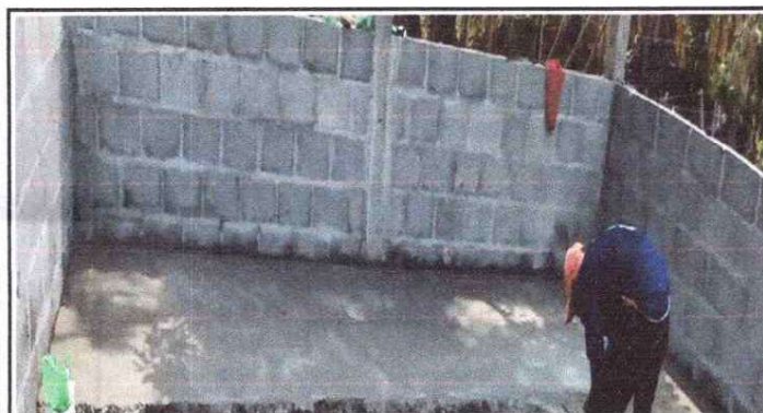
Sustitución de piso de torta de concreto
