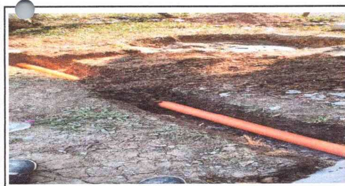
Limpieza de fosa Séptica
