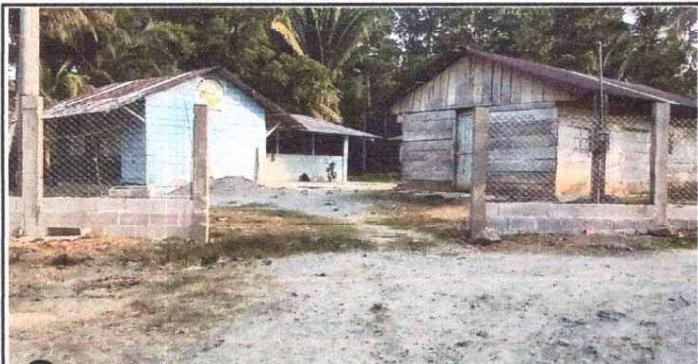
Fabricación e Instalación de Portón de Ingreso
