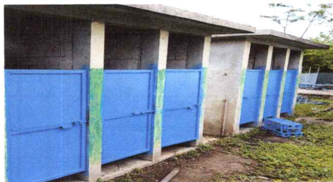
3. Puerta de sanitarios reparada
