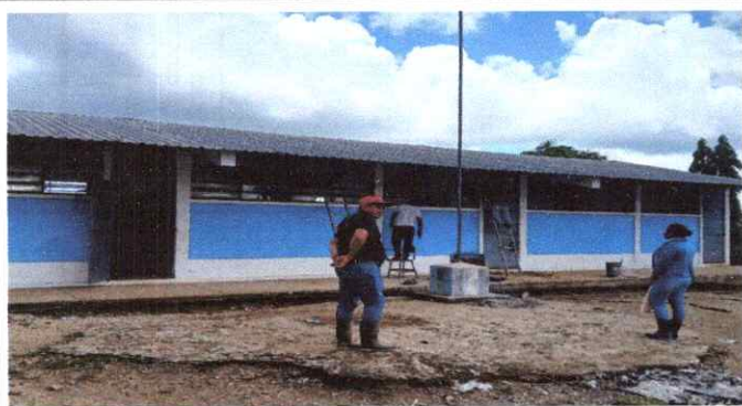
1. Láminas instaladas troquelada calibre 2
