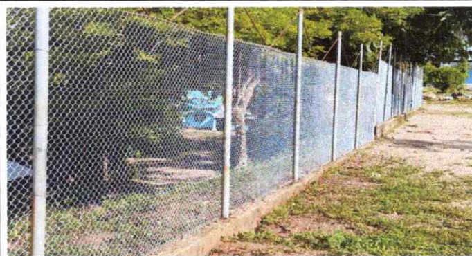
4. Malla instalada galvanizada
