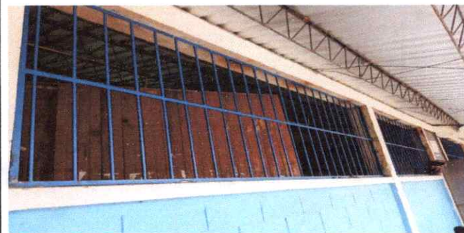
6. Estructura de metal de ventana instalada.
