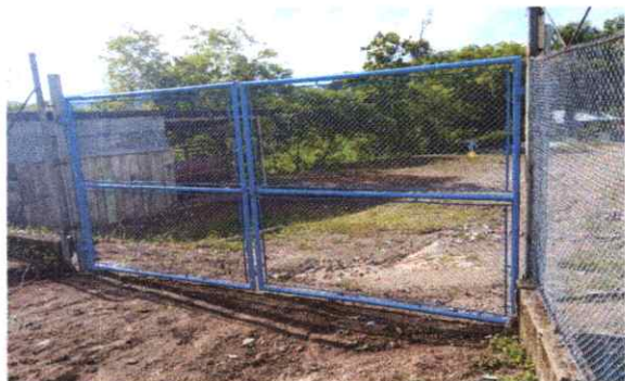
5. Portón principal reparada.
