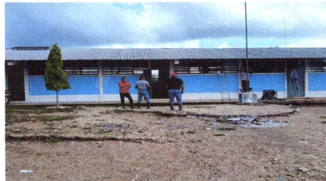
2. Se observa láminas instalada
