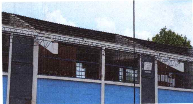
1.Desinstalación de lámina
