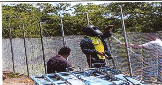
4. Colocación de malla galvanizada
