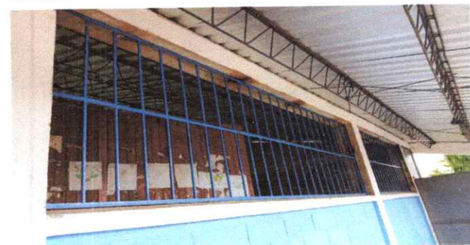
5. Estructura de metal de ventana
