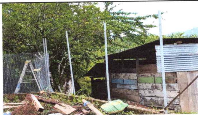
3. Desinstalación de malla
