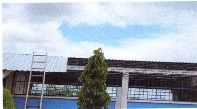
2. Instalación de lámina troquelada calibre 26
