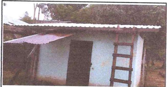
FOTO 4: Sustitución de Soporte de Madera, por Metal en Baños, Sustitución de lámina por lámina troquelada Calibre 26 en Baños
