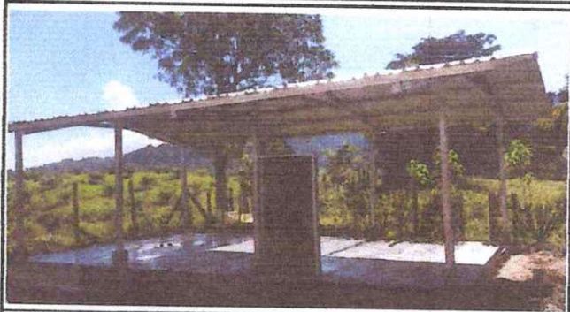
FOTO 2: Sustitución de Soporte de Madera, por Metal y Colocación de Columnas de Metal en Aula, Sustitución de lámina por lámina troquelada Calibre 26 en Aula
