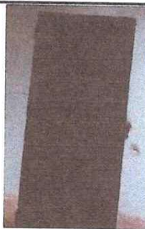
FOTO 3: Fabricación e Instalación de Puerta en Baños
