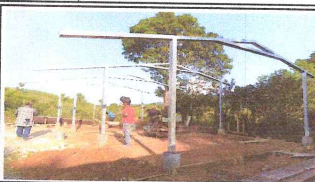
FOTO 2: Sustitución de Soporte de Madera, por Metal y Colocación de Columnas de Metal en Aula, Sustitución de lámina por lámina troquelada Calibre 26 en Aula
