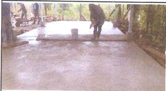
FOTO 3: Sustitución de Piso de Cemento líquido
