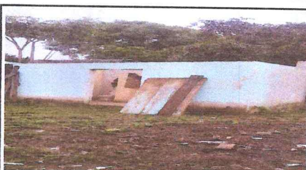
FOTO 4: Sustitución de Soporte de Madera, por Metal en Baños, Sustitución de lámina por lámina troquelada Calibre 26 en Baños
