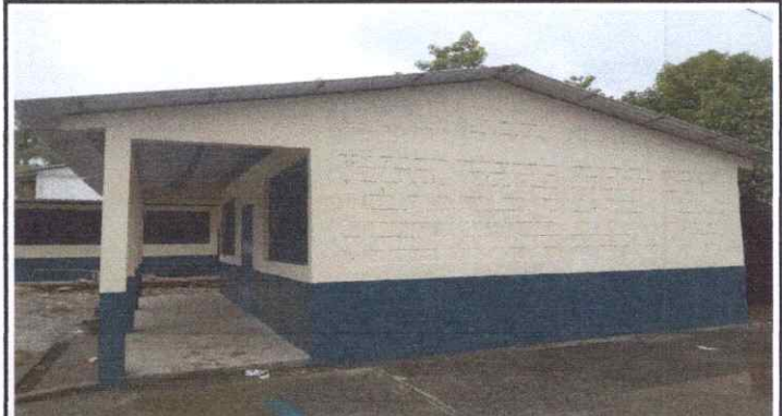
FOTO 4: Pintura en muros exteriores e interiores
