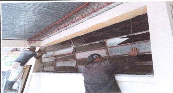
FOTO 3: Sustrucción de estructura de metal de ventana
