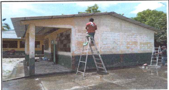
FOTO 4: Pintura en muros exteriores e interiores
