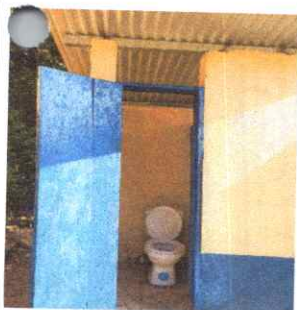
FOTO 5: Sustitución de inodoro y Repello en Paredes de baños
