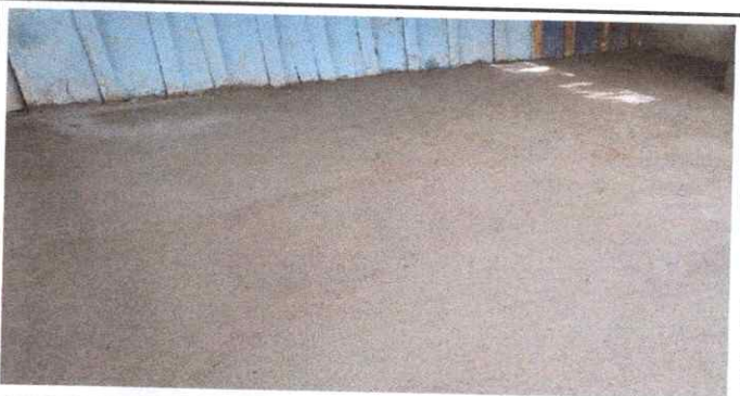
FOTO 6: Sustitución de piso de torta de concreto en cocina
