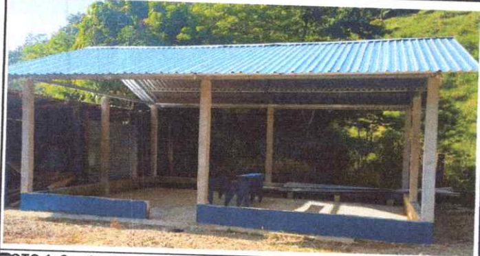
FOTO 1: Sustitución de lámina, por lámina troquelada aluzinc calibre 26 Sustitución de estructura de soporte de madera, por metal
