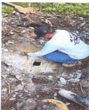
FOTO 3: Limpieza de fosa séptica.
