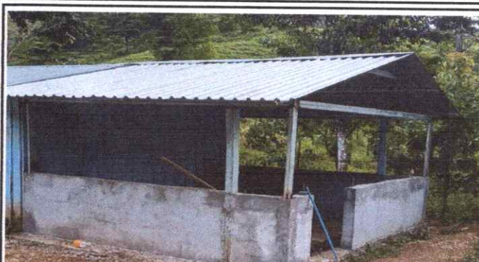
FOTO 2: Sustitución de lámina, por lámina troquelada aluzinc calibre 26 en cocina Y Sustitución de estructura de soporte de madera, por metal en cocina
