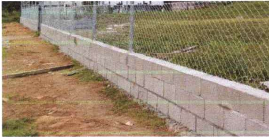
FOTO 1: LEVANTADO DE MURO PERIMETRAL
