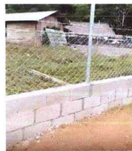
FOTO 4: LEVANTADO DE MURO PERIMETRAL
