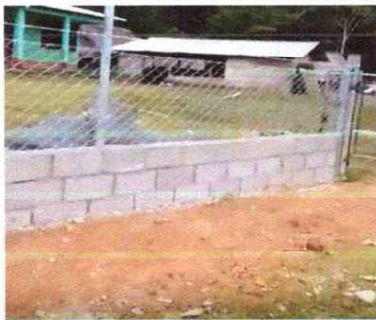
FOTO 3: LEVANTADO DE MURO PERIMETRAL
