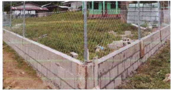
FOTO 2: LEVANTADO DE MURO PERIMETRAL
