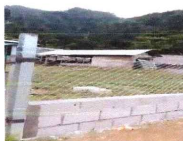
FOTO 6: LEVANTADO DE MURO PERIMETRAL
