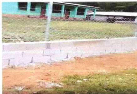
FOTO 5: LEVANTADO DE MURO PERIMETRAL
