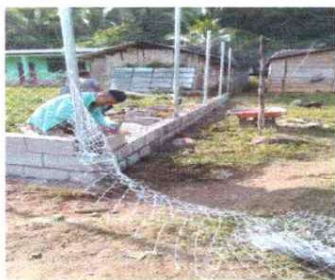
FOTO 5: INSTALACION DE MALLA EN MURO PERIMETRAL
