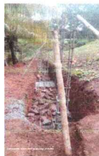
FOTO 2: ZANJA PARA SOPORTE DE LEVANTADO DE MURO
