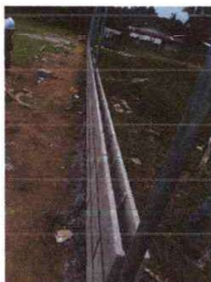
FOTO 3: LEVANTADO DE MURO DE CONCRETO
