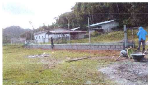
FOTO 6: INSTALACION DE MALLA EN MURO PERIMETRAL
