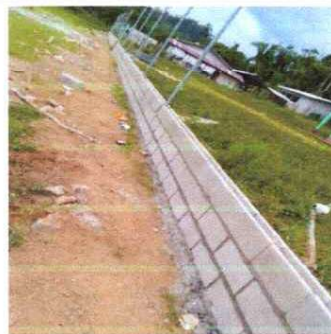
FOTO 4: LEVANTADO DE MURO DE CONCRETO
