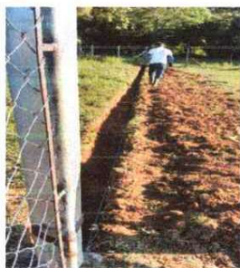
FOTO 1: ZANJA PARA SOPORTE DE LEVANTADO DE MURO
