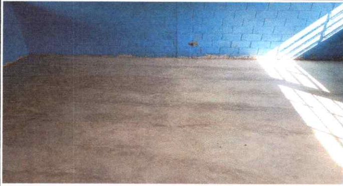
FOTO 1: Sustrucción de piso de cemento liquido
