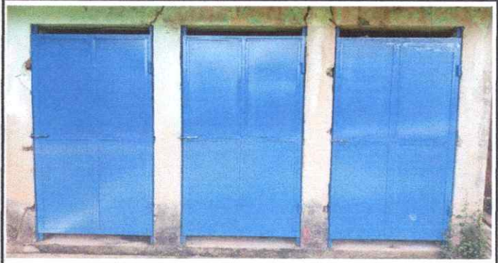
FOTO 2: Fabricación e instalación de puertas de metal en baños
