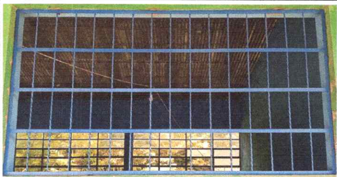
FOTO 3: Fabricación e Instalación de Balcones.
