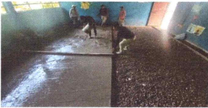
FOTO 1: Sustrucción de piso de cemento liquido
