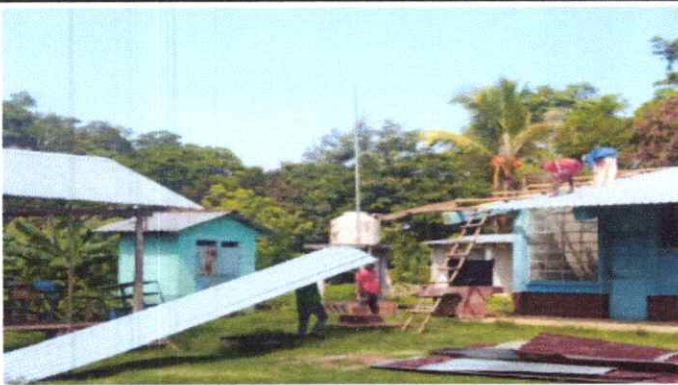
1 Sustitución de lámina, por lámina troquelada aluzinc calibre 26,
