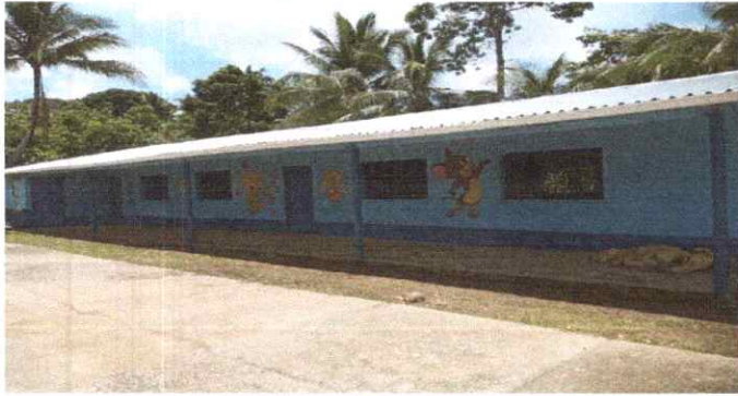
1. Láminas instalada de las 2 aulas
