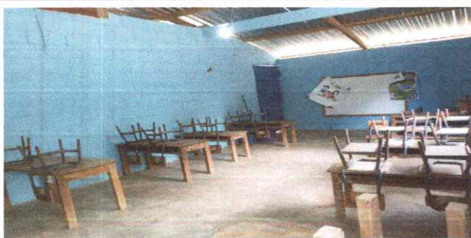
5. Pintura en muro interior
