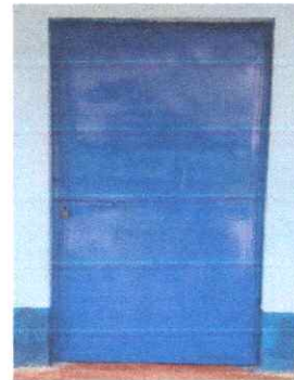
4. Puerta de metal instalada
