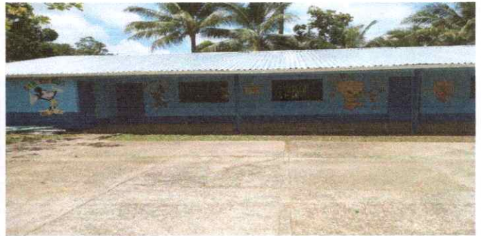
2. Se observa láminas instalada
