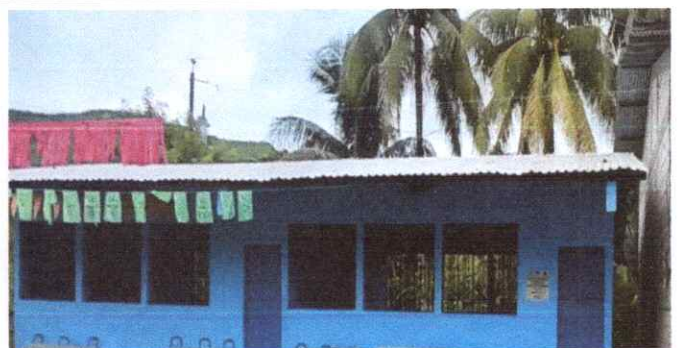
6. Pintura en exterior finalizada
