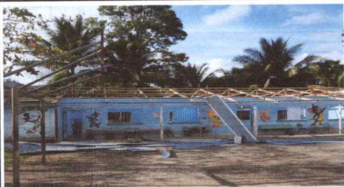
1. Desinstalación de lámina
