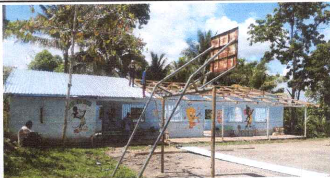
2. Instalación de lámina troquelada calibre 26
