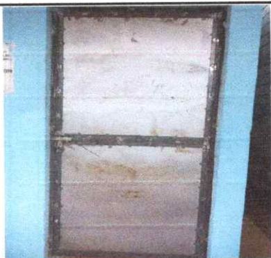
3. colocación de puerta de metal
