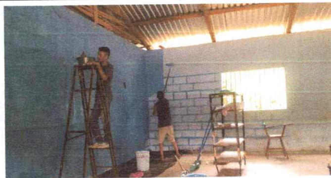
6. Pintura en muro interior
