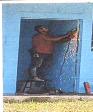
4. Instalación de puerta de metal
