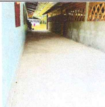
Foto 4: Se colocó piso de losa fuera de las aulas.
