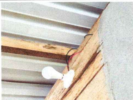
Foto 3: Finalización de cambios de cableado eléctrico en las aulas
