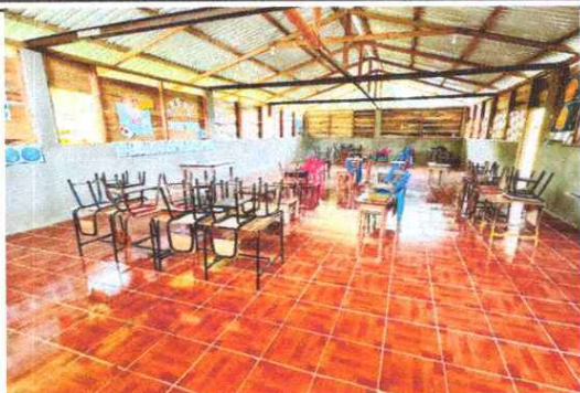
Foto1: Se finaliza el trabajo en las aulas, piso cerámico color madera.
