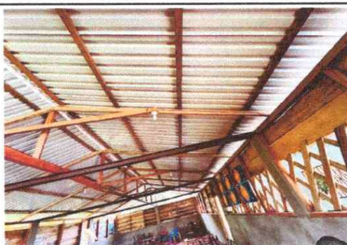
Foto 2: Láminas troqueladas para las aulas.
