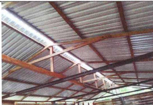
Foto 2: Se colocan las laminas troqueladas.
