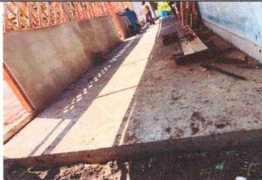
Foto 4: Se hace la torta de cemento y se procede a llenar los espacios.
