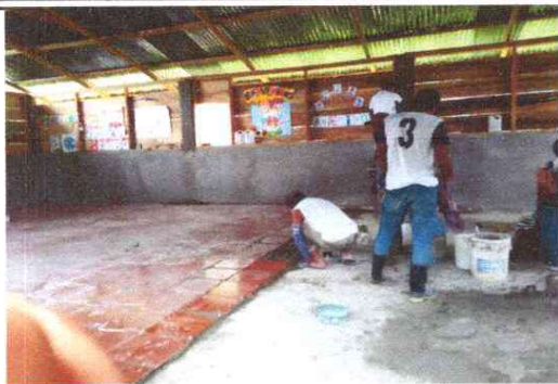
Foto1: Se avanza con el pegado de piso cerámico.
