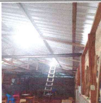
Foto 3: Se hace prueba de los focos y cables de energía eléctrica.
