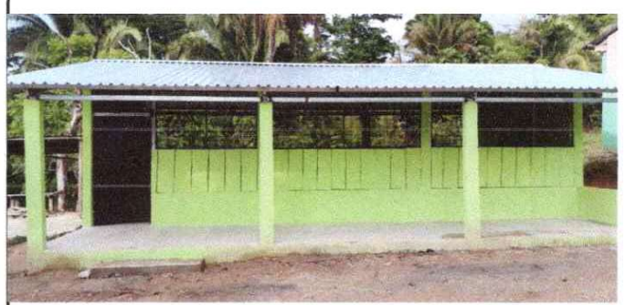
foto 2 sustitucion de lamina por lamina Aluzinc calibre 26
