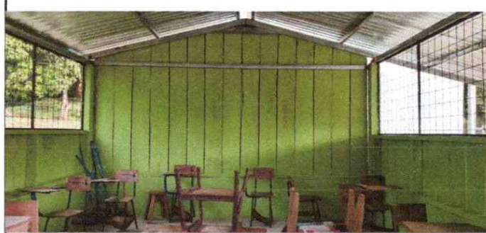
foto 6 pintura en muros exteriores e interiores
