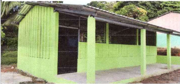
foto 3 sustitucion de puerta
