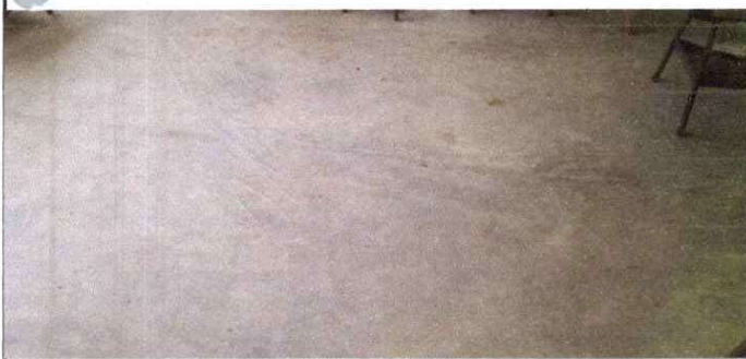
foto 5 sustitucion de piso de torta de concreto
