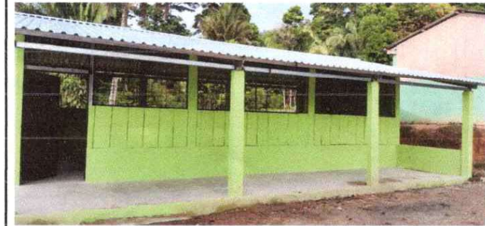
foto 4 sustitucion de estructura de metal de ventana
