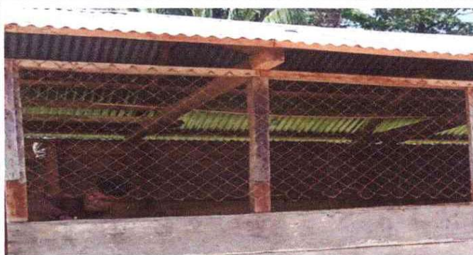
foto 4 sustitucion de estructura de metal de ventana
