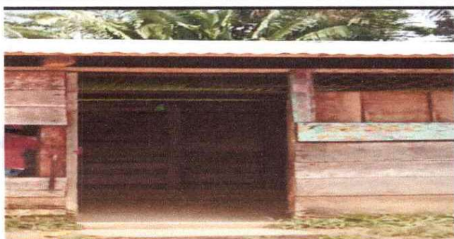
foto 3 sustitucion de puerta
