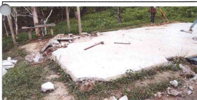
foto 5 sustitucion de piso de torta de concreto
