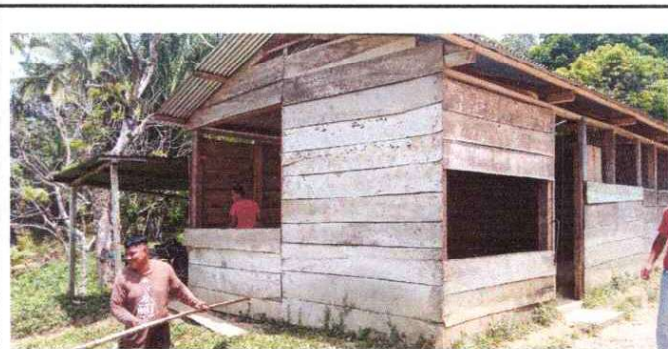
foto 6 pintura en muros exteriores e interiores
