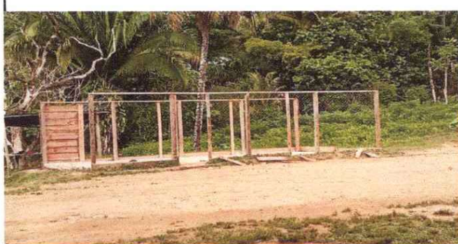
foto 2 sustitucion de lamina por lamina Aluzinc calibre 26
