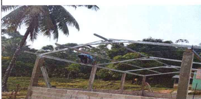
foto 1 Sustrucción de estructura de soporte de madera por metal
