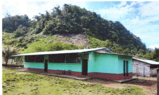
FOTO 3: PINTURA EN MURO INTERIOR Y EXTERIOR
