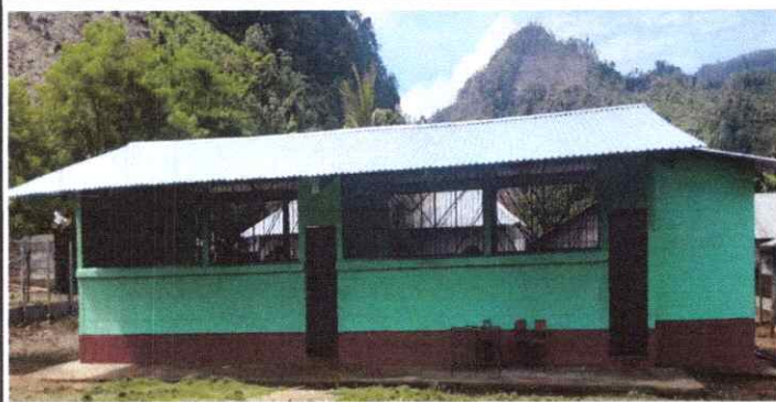
FOTO 1: MANTENIMIENTO A ESTRUCTURA DE METAL
