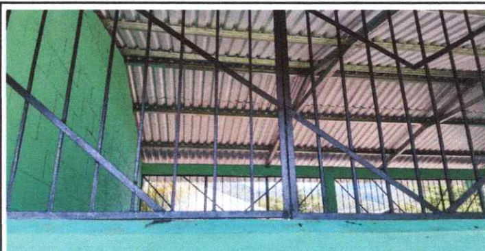
FOTO 6: MANTENIMIENTO A BALCONES
