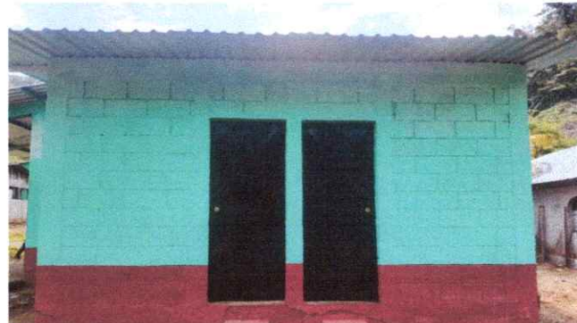
FOTO 4: MANTENIMIENTO Y SUSTICION DE CHAPAS EN PUERTAS DE METAL
