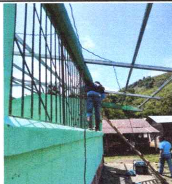
FOTO 5: SUSTITUCION ESTRUCTURA DE SOPORTE DE MADERA POR METAL
