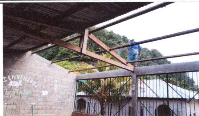
FOTO 2: SUSTITUCION DE LAMINA POR LAMINA TROQUELADA CALIBRE 26
