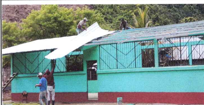
FOTO 3: SUSTITUCION DE LAMINA POR LAMINA TROQUELADA CALIBRE 26
