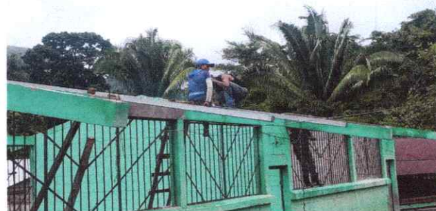
FOTO 6: SUSTITUCION DE ESTRUCTURA DE SOPORTE DE MADERA POR METAL
