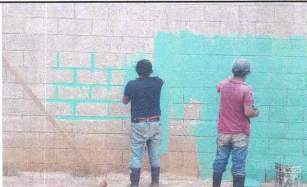
FOTO 7: PINTURA EN MURO INTERIOR Y EXTERIOR
