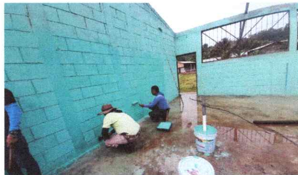
FOTO 8: PINTURA EN MURO INTERIOR Y EXTERIOR
