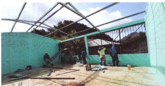
FOTO 9: MANTENIMIENTO AL BALCONES
