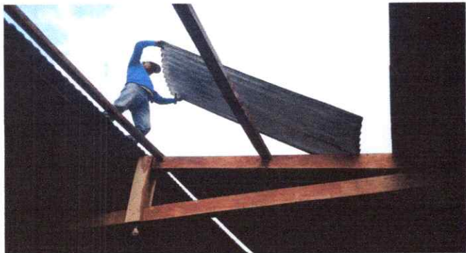
FOTO 1: SUSTITUCION DE LAMINA POR LAMINA TROQUELADA CALIBRE 26
