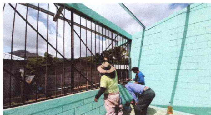
FOTO 10: MANTENIMIENTO A BALCONES
