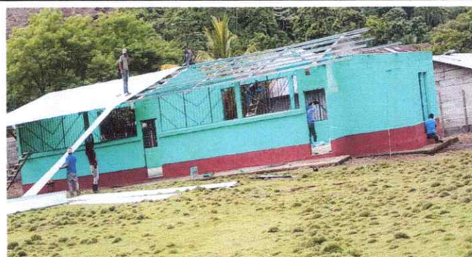
FOTO 4: SUSTITUCION DE LAMINA POR LAMINA TROQUELADA CALIBRE 26
