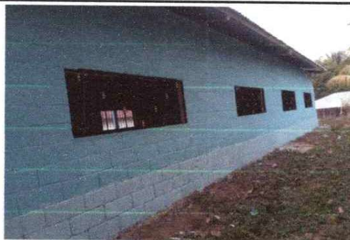
REMOZAMIENTO DE PINTURA
