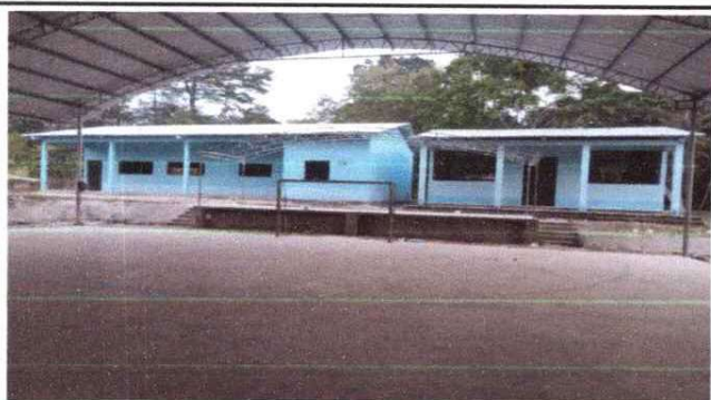
REMOZAMIENTO DE CORREDOR Y TECHO
