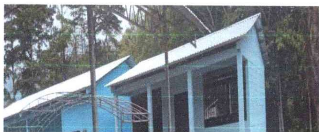
Cambio de techo
