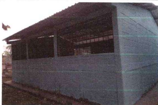
REMOZAMIENTO DE BALCONES
