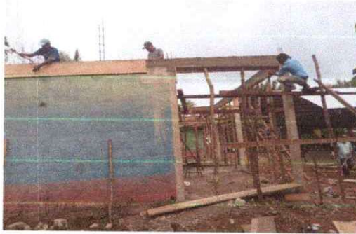
Foto1: Reparación de bigas para colocar costaneras
