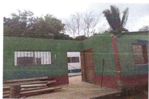
Foto 2: dismantlar el techo
