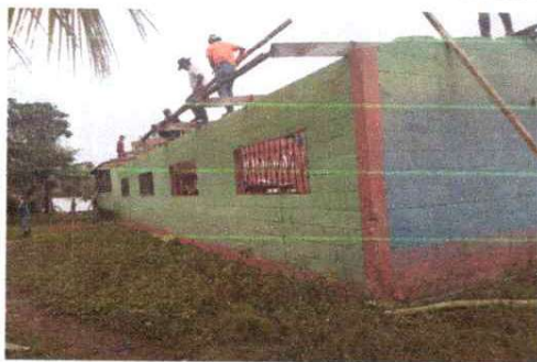
Foto 5: Colocando las costaneras
