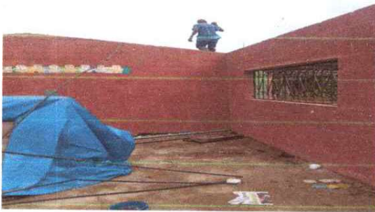
Foto 3: mejoramiento de pared
