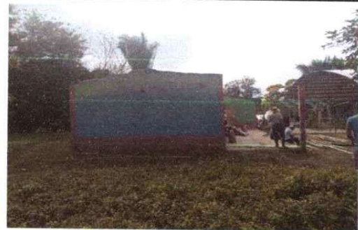
Foto 4: Inicio de mejoramiento de techado
