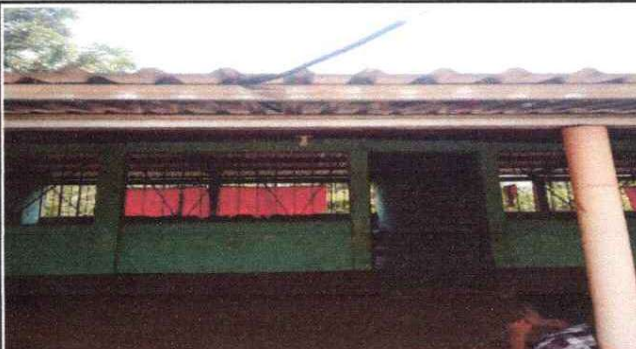
FOTO 4: Sustrucción de ducto eléctrico + accesorios
