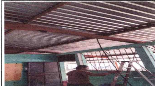
FOTO 4: Sustitución de ducto eléctrico + accesorios
