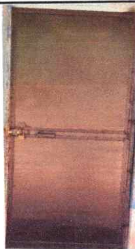
4. Puerta de metal instalada
