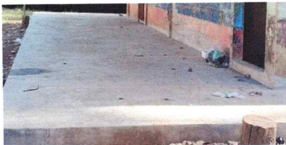
2. Instalación de placa de patio y cemento de concreto
