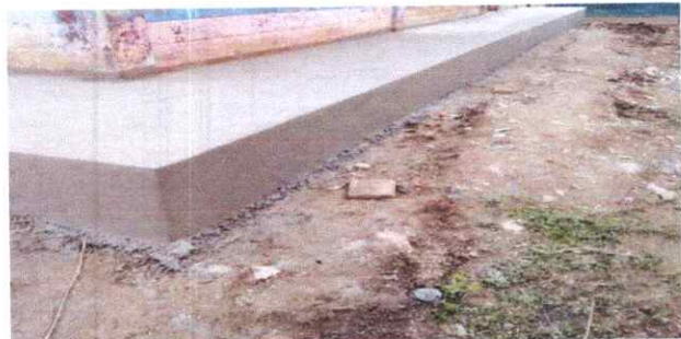
1. Instalación de losa de patio
