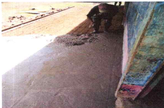
3. Instalación de concreto de cemento
