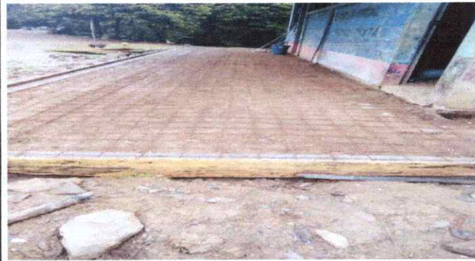
2. Instalación de plancha de concreto de patio
