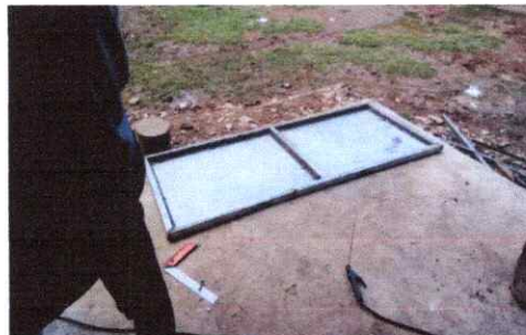
4. Frabricación de puerta de metal
