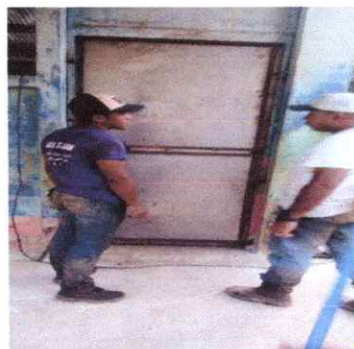
6. Puerta de metal instalada
