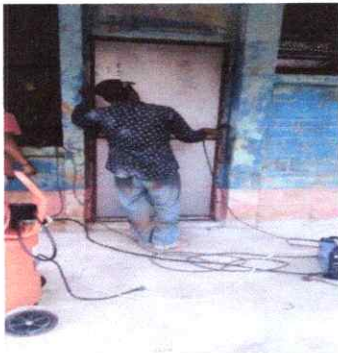
5. Instalación de puerta de metal
