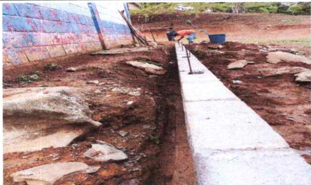
1. Reparación de losa de patio
