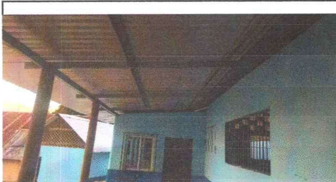
Finalización de la remodelación del corredor principal de la escuela.
