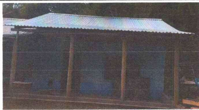
Remodelación terminada del salón de parvulos.
