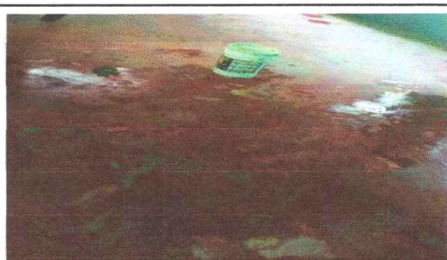
Dando los ultimos toques del piso del salon de sexto primaria,
