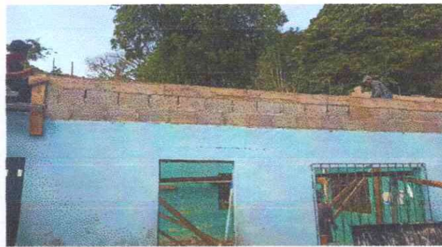
Preparando el salon de parvulos para armar la estructura metalica
