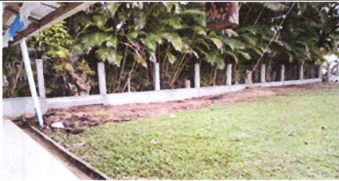
FOTO 1: SUSTITUCION DEMURO PERIMETRAL LADO DERECHO.
