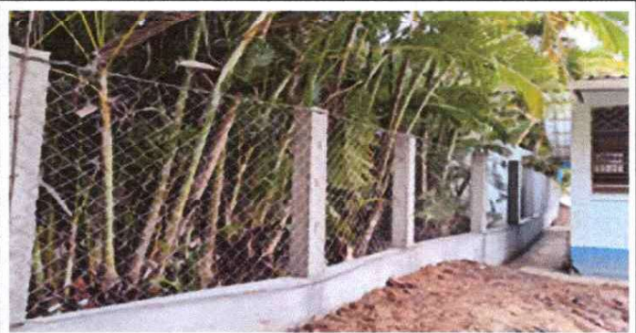
FOTO 2: SUSTITUCION DE MURO PERIMETRAL LADO DERECHO.
