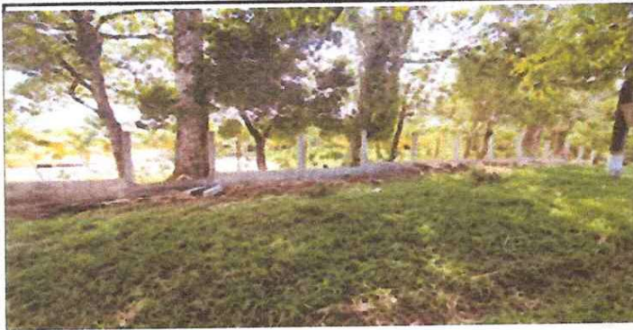
FOTO 1: SUSTITUCION DEMURO PERIMETRAL LADO DERECHO.
