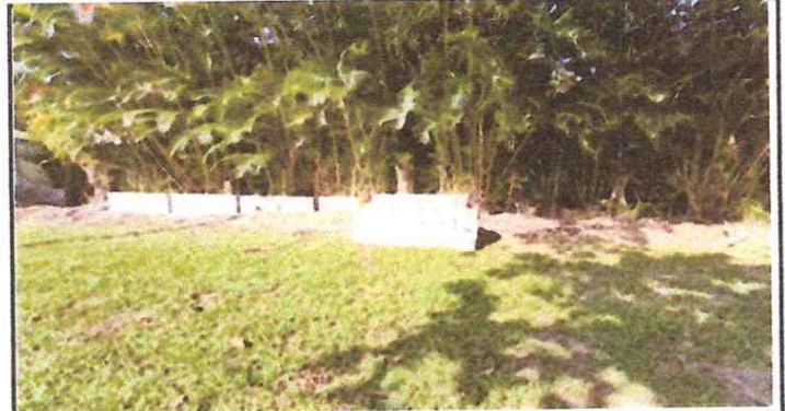
FOTO 2: SUSTITUCION DE MUOPERIMETRAL LADO IZQUIERDO.
