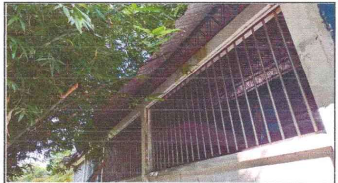
Foto 2: Sustrucción de balcones, aulas de primero B y segundo A
