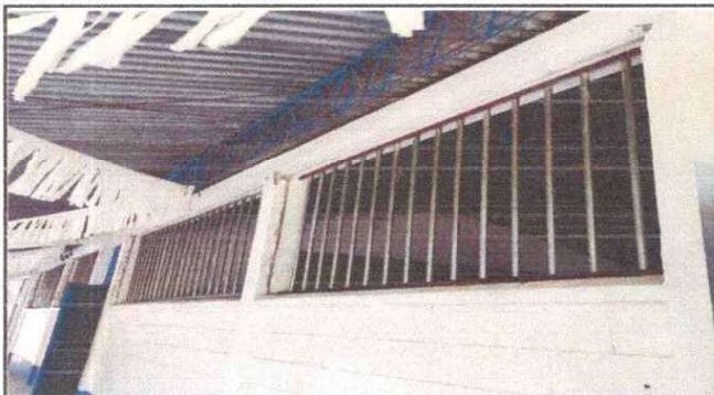
Foto 1: Sustrucción de balcones, aulas de primero B y segundo A
