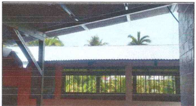
Foto 4: Sustrucción de lámina, aula de tercero A
