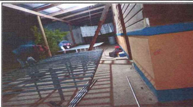
Foto 1: Sustrucción de balcones
