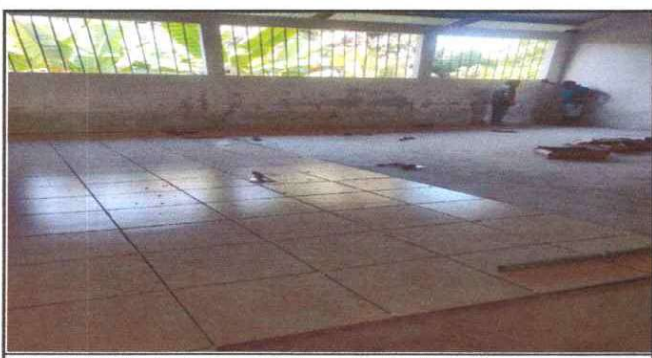
Foto 5: Sustrucción de piso cerámico, aula de primero A
