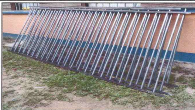
Foto 2: Sustrucción de balcones
