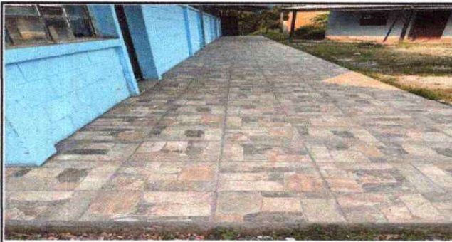
Foto 1: SUSTITUCIÓN DE PISO CERÁMICO ÁREA DEL CORREDOR
