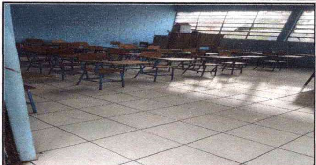
Foto 2: SUSTITUCIÓN DE PISO CERÁMICO AULA DE PRIMERO BÁSICO
