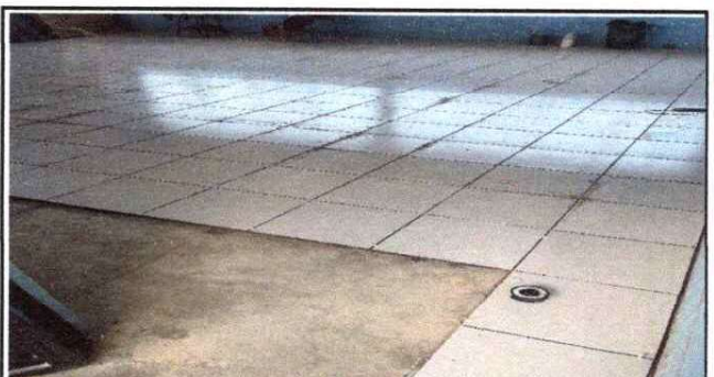
Foto 4: SUSTITUCIÓN DE PISO CERÁMICO AULA DE TERCERO BÁSICO
