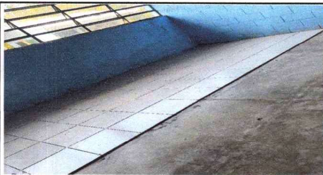
Foto 3: SUSTITUCIÓN DE PISO CERÁMICO AULA DE SEGUNDO BÁSICO
