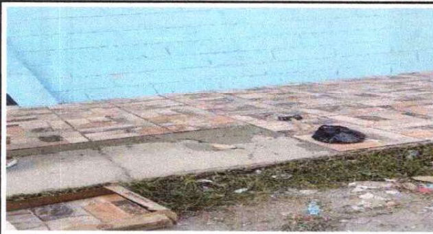
Foto 1: SUSTITUCIÓN DE PISO CERÁMICO ÁREA DEL CORREDOR
