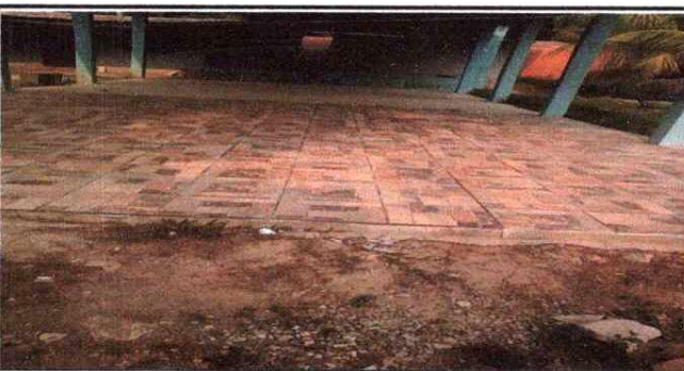
Foto 5: SUSTITUCIÓN DE PISO CERÁMICO DEL ESCENARIO
