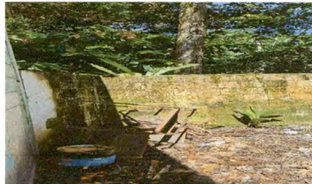
Foto 8: SUMINISTRO Y COLOCACION DE PISO CERAMICO ANTIDESLIZANTE
