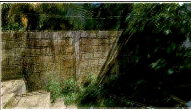
Foto 6: AMPLIACION MURO EN AULA CON REFUERZO ESTRUCTURAL.
