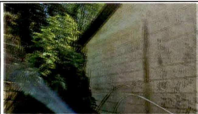
Foto 5: SUMINISTRO E INSTALACION DE ESTRUCTURA METALICA
