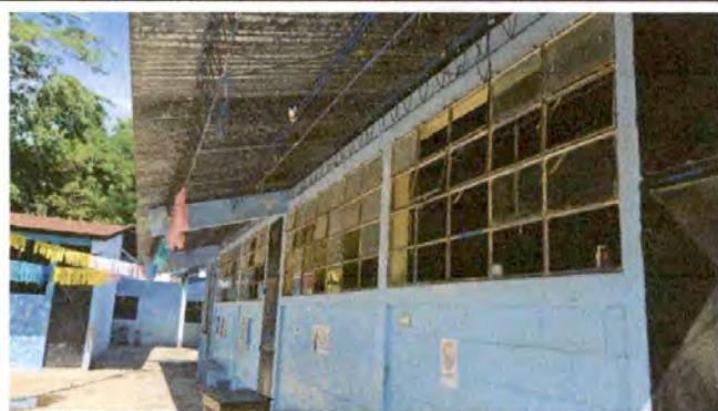
Foto 11: SUMINISTRO E INSTALACION DE BALCONES DE METAL
