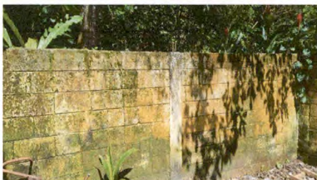
Foto 7: AMPLIACION MURO EN AULA CON REFUERZO ESTRUCTURAL
