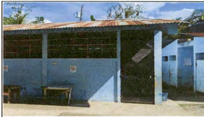
Foto 10: SUMINISTRO E INSTALACION DE BALCONES DE METAL
