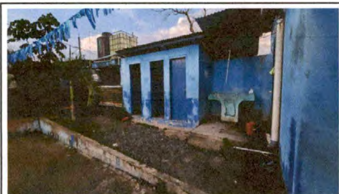
Foto 9: MODULO "C" SERVICIO SANITARIO REMOZAMIENTO DE TECHO, REMOZAMIENTO DE PUERTAS PINTURA EN GENERAL, MEJORAMIENTO DE INSTALACIONES DE AGUA POTABLE
