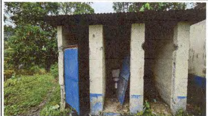
Foto 10: MODULO "B" SUMINISTRO E INSTALACION DE LAMINA TROQUELADA CAL, 26 SUMINISTRO E INSTALACION DE PUERTA CON PASADOR
