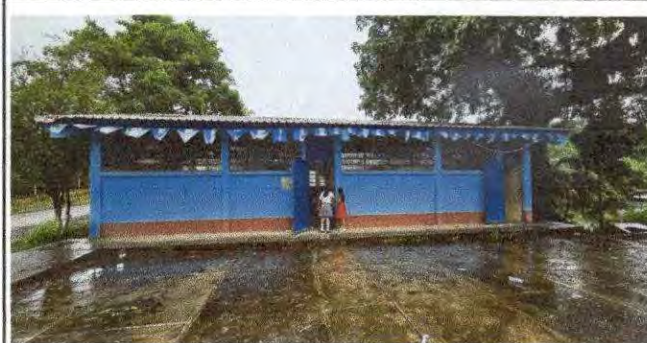
Foto 2: REMOZAMIENTO DE ESCUELA
