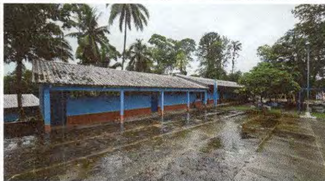
Foto1: . REMOSAMIENTO DE ESCUELA EN AULAS, Y SERVICIO SANITARIO
