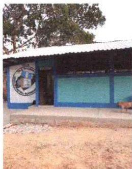
Foto 1: Sustrucción de techo.
