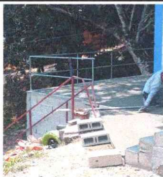
Foto 5: Muro de contención finalizado.
