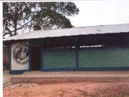
Foto 2: Sustrucción de techo.
