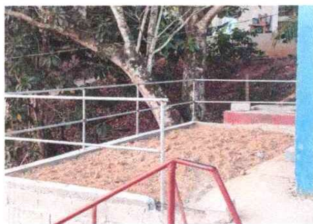
Foto 5: Reparación de muro de contingencia.
