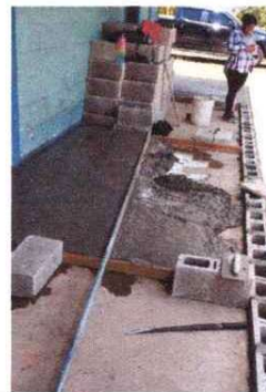
Foto 6: Reparación de banqueta frontal.
