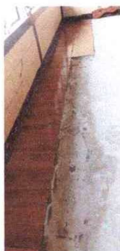
Foto 3: Colocación de piso cerámico en salón de clases.
