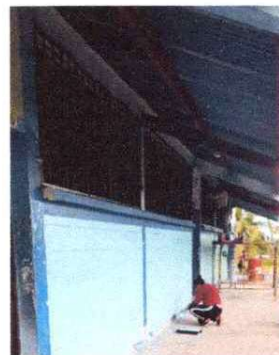
Foto 4: Proceso de pintura en el establecimiento.
