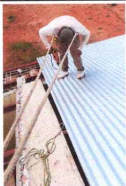
Foto1: Proceso de cambio de láminas.
