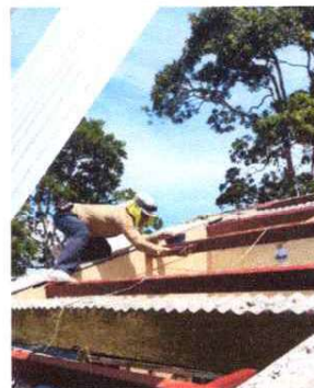
Foto 2: Proceso de cambio de láminas.
