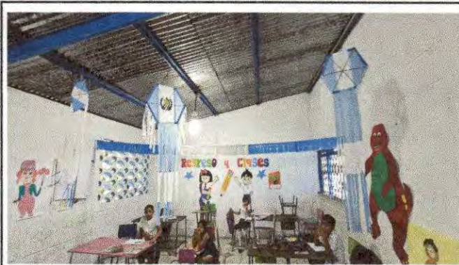
Foto 8: SUMINIISTRO E INSTALACION DE CIELO FALSO EN AULA
