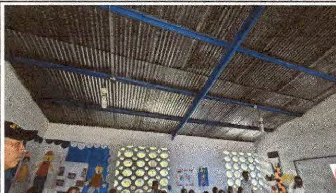
Foto 7: . COLOCACION DE CIELO FALSO
