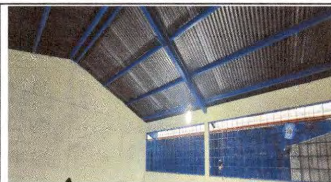
Foto 11: REMOZAMIENTO DE TECHO.
