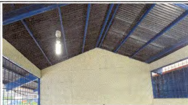
Foto 9: REMOZAMIENTO DE TECHO, SUMINISTRO E INSTALACION DE CIELO FALSO
