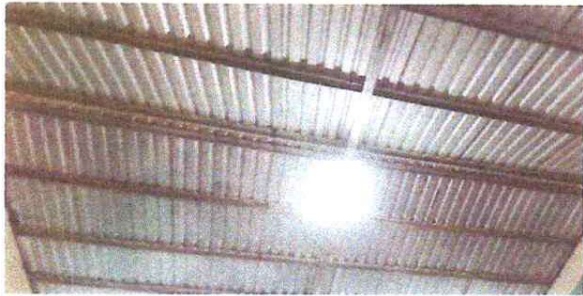
Foto 1: REPARACION DE CABLEADO ELECTRICO
