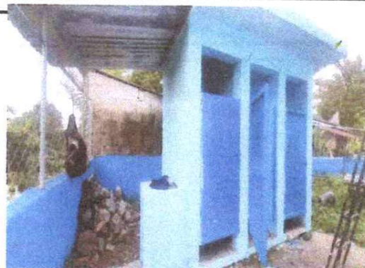
Foto 4: MANTENIMIENTO A ESTRUCTURAS A SERVICIO SANITARIO
