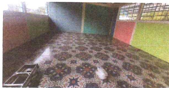
Foto 2: SUSTITUCION DE PISO CERAMICO
