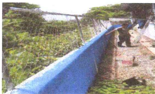
Foto 5: REPARACION DE TUBO HG Y MALLA GALVANIZADA
