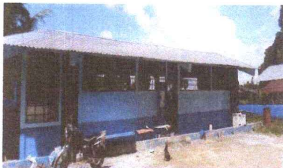
Foto1: SUSTITUCION DE ESTRUCTURA DE METAL
