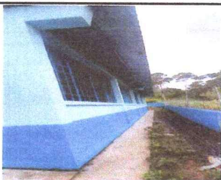
Foto 3: PINTURA EN MURO EXTERIORES E INTERIORES
