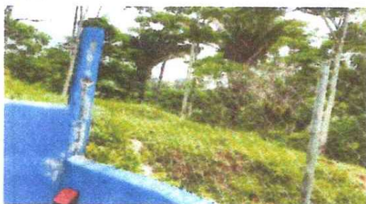
Foto 5: REPARACION DE TUBO HG
