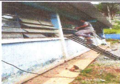
Foto 3: PINTURA EN MURO EXTERIOR E INTERIOR
