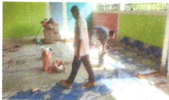
Foto 2: SUSTITUCION DE PISO CERAMICO
