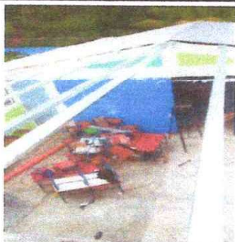
Foto 1: SUSTITUCION DE ESTRUCTURA DE METAL
