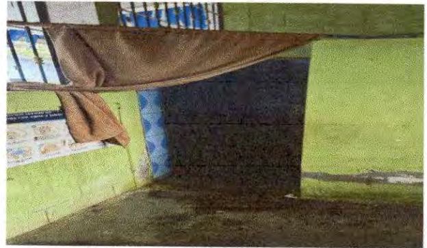
Foto 10: REMOZAMIENTO DE BAÑOS
