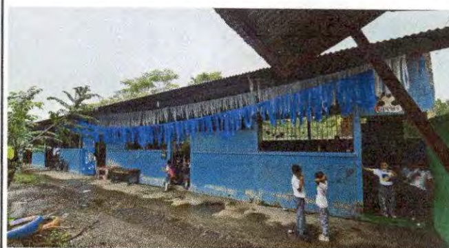
Foto 2: REMOZAMIENTO DE AULAS
