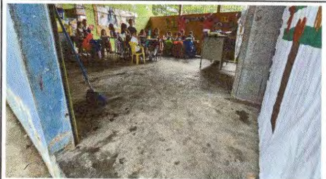
Foto 12: REMOZAMIENTO DE PISO
