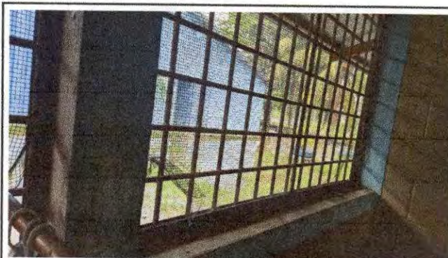
Foto 6: SUMINISTRO Y COLOCACION DE CEDAZOMOSQUITERO.
