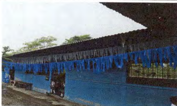
Foto 3: REMOZAMIENTO DE AULAS
