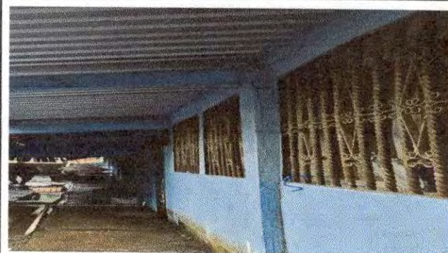
Foto 4: SUMINISTRO Y COLOCACION DE CEDAZOMOSQUITERO.
