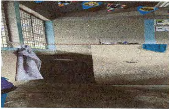
Foto 9: REMOZAMIENTO DE BAÑOS
