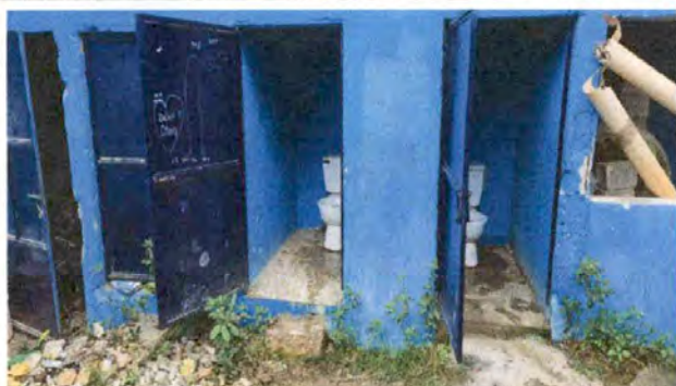
Foto 5: REMOZAMIENTO SERVICIO SANITARIO
