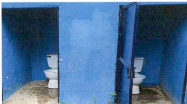
Foto 7: SUMINISTRO E INSTALACION DE INODORO
