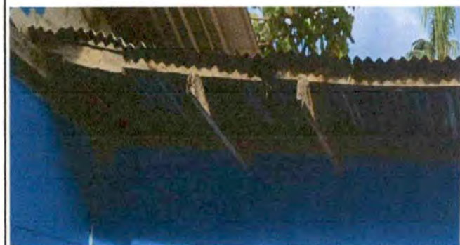
Foto 4: SUMINISTRO E INSTALACION DE ESTRUCTURA METALICA
