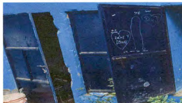
Foto 6: SUMINIISTRO E INSTALACION DE PUERTA CON PASADO
