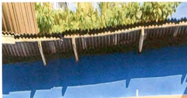
Foto 3: SUMINIISTRO E INSTALACION DE LAMINA TROQUELADA CALIBRE, 26
