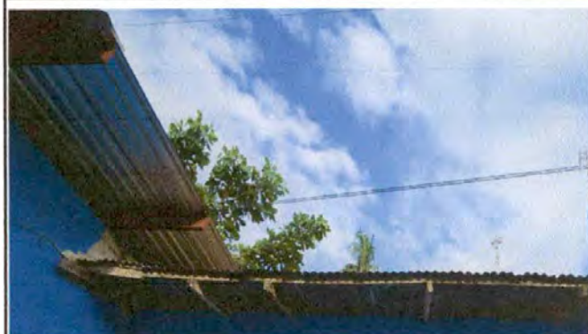
Foto 2 REMOZAMIENTNO DE SERVICIO SANITARIO SUMINIISTRO E INSTALACION DE LAMINA TROQUELADA CAL, 26
