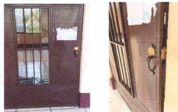
Foto No. 19 se realizó la sustitución de chapa de puertas de metal en las aulas.
