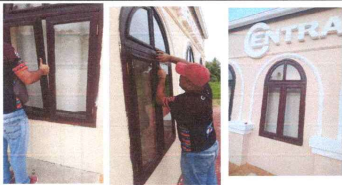
Foto No. 13 y 14 se realizó la Sustitución de vidrios y colocación de marco a ventanas
