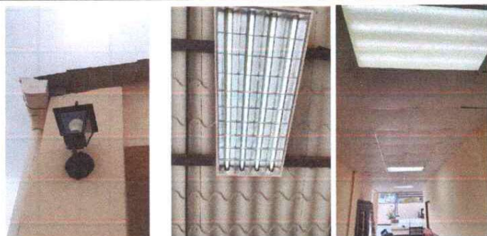
Foto No. 20, 21 y 22 se llevo a cabo la reparación del sistema eléctrico y sustitución de lamaparas de 2x 20
