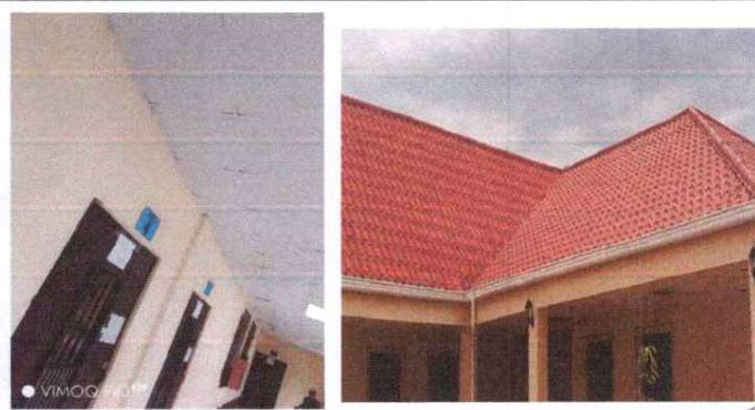
Foto No. 15 y 16 se realizó el mantenimiento y estructura de aplicación de pintura y cambio de cielo falso.
