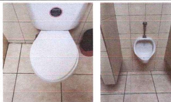
Foto No. 23 se realizó la sustitución de accesorios para baños como lo que es la tapadera y mingitorio.
