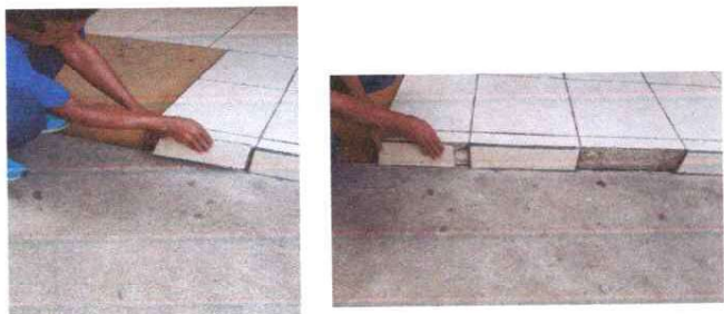
Foto No. 17 y 18 se esta llevando a cabo la reparación de piso ceramico.
