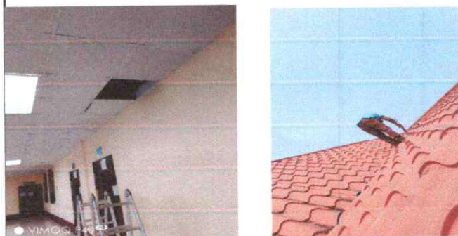
Foto No. 15 y 16 se esta realizando el mantenimiento estructura y aplicación de pintura de techo
