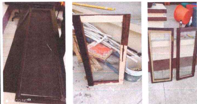
Foto No. 13 y 14 se quitaron las ventanas para sustitución de vidrios
