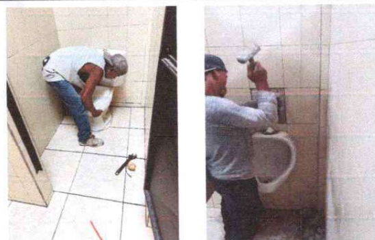
Foto No. 23 se lleva a cabo la sustitución de accesorios para baños su tapadera, y sustitución de llave mingitorio.
