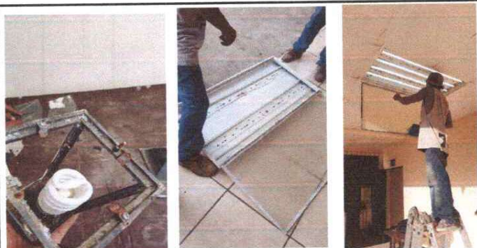
Foto 21 y 22 se lleva a cabo la reparación de sistema eléctrico, sustitución de lamparas de 2x20
