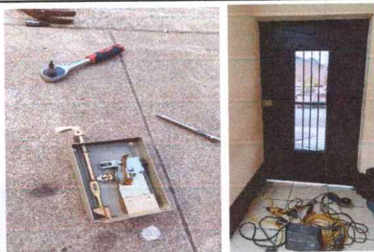
Foto No. 19 se realiza la sustitución de chapa de puertas de metal.
